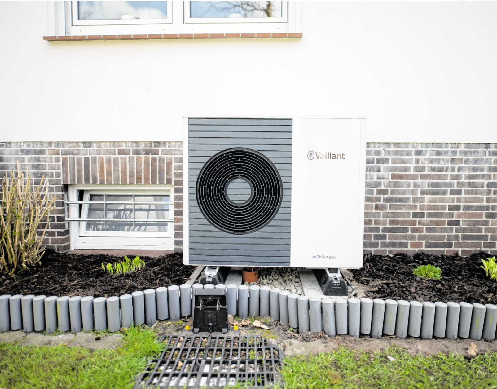
Zusätzliche Kosten drohen, wenn beim Wechsel auf eine Wärmepumpe Leistungen als „bauseitig“ ausgewiesen sind.
