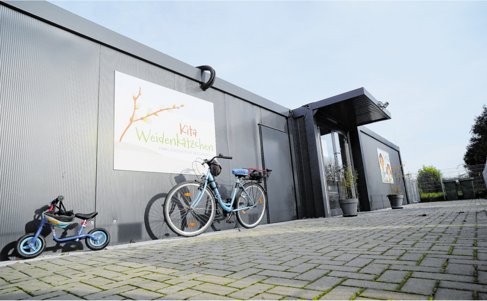
Die Kita Weidenkätzchen in Bensheim wurde 2021 eröffnet. Der Betrieb in den Containern ist noch bis Sommer 2027 gesichert.
